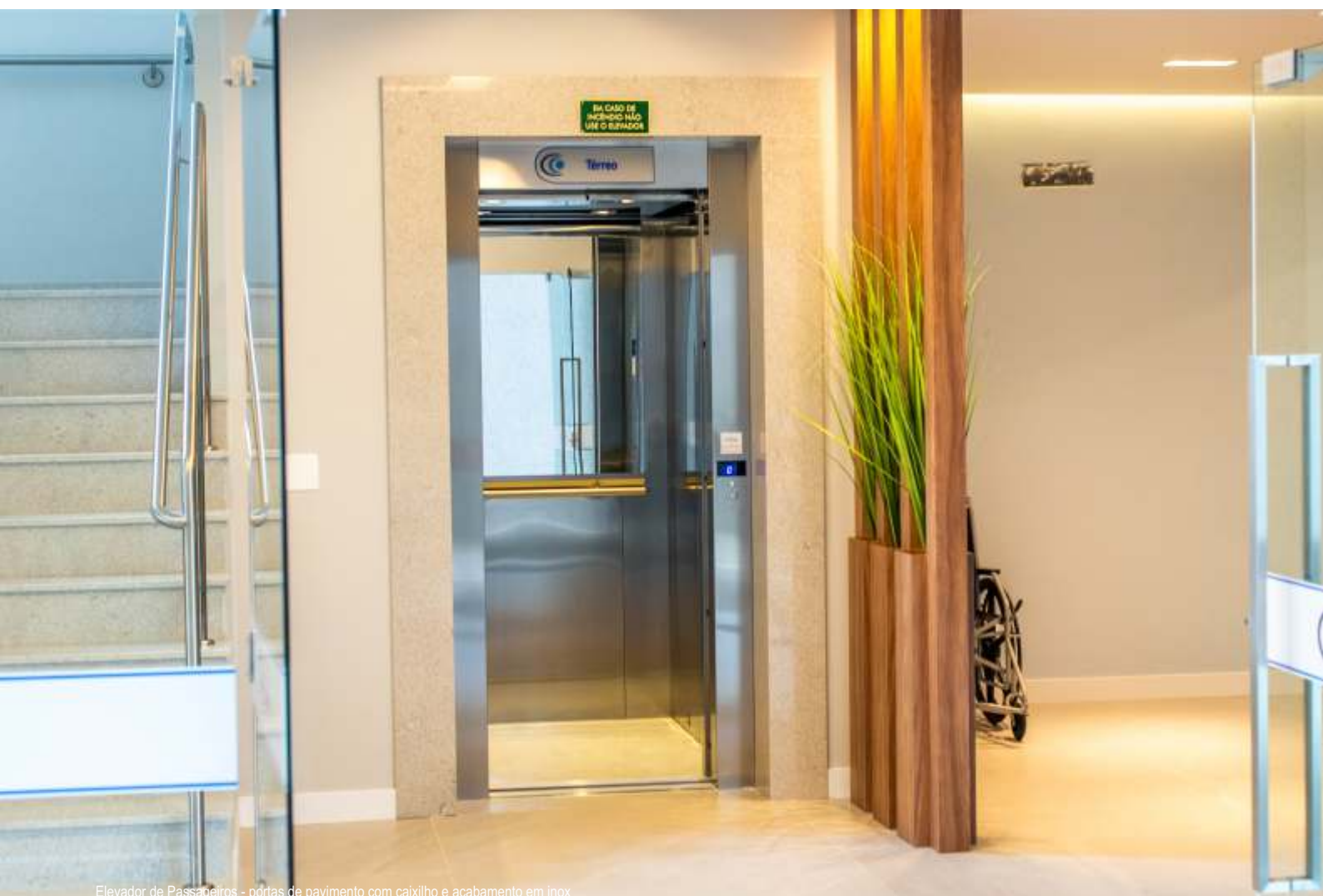
Elevador de Passageiros - portas de pavimento com caixilho e acabamento em inox
