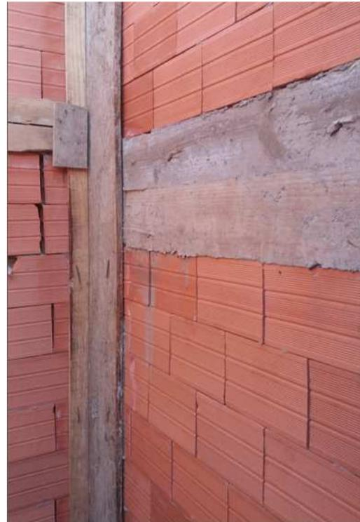
Não é obrigatória a execução de reboco nas paredes internas da caixa de corrida.
